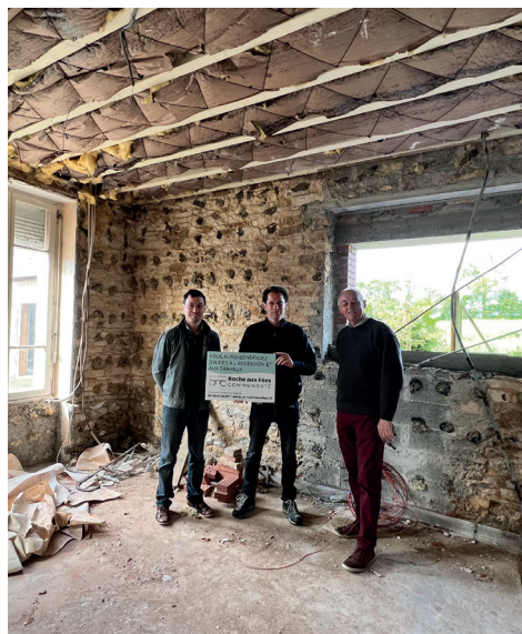
Chantier de rénovation thermique de maison.
