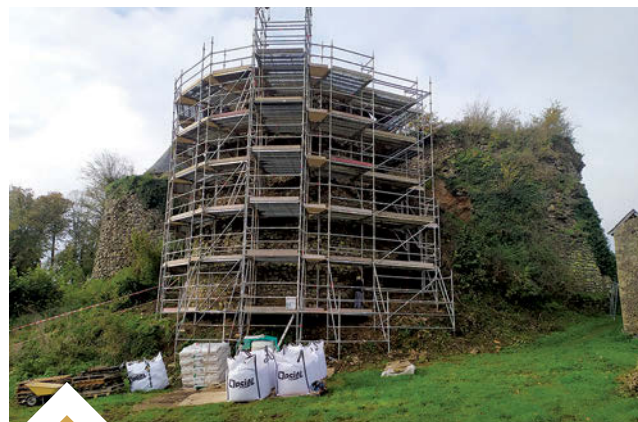
Château de Marcillé-Robert, tranche 2 des travaux
