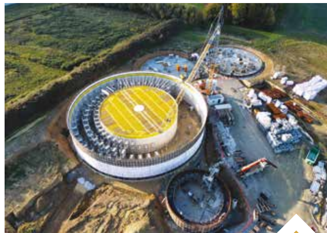
Chantier de construction : unité de méthanisation Enerfées
