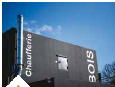
La chaufferie-bois de Coësmes
