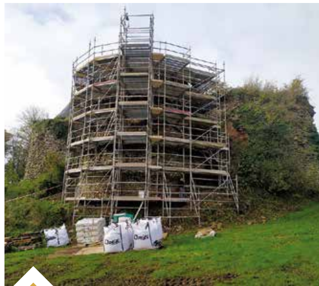
Tour en restauration, château de Marcillé-Robert
