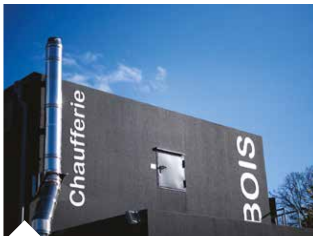
La chaufferie-bois de Coësmes
